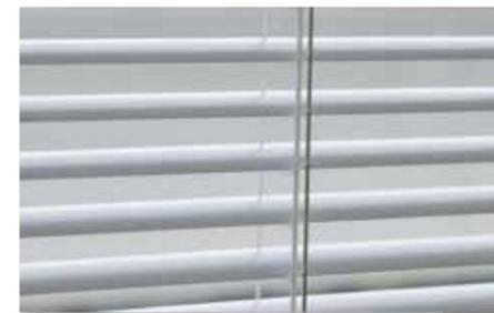
連窓には自動で降下するブラインドで使いやすいユニタッチ25高遮蔽タイプが採用されました。スラットの重なり幅が大きく、昇降コード穴がないので光漏れを少なくすることができます。試験などの際には廊下側、窓側からの光漏れが答案用紙に映ることを防げます。
