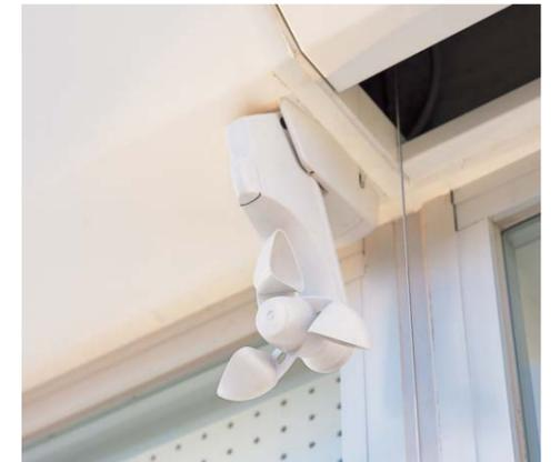
風の強さを感知する風力センサーからの情報は、制御盤を通して各フロア全てのロールスクリーンと連動し制御されており、風速が6mを越えると自動的にスクリーンが上昇します。
