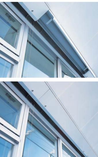
劣化防止、安全確保のために、未使用時のロールスクリーンは上部に収納。外部の美観も損なわない構造になっています。
