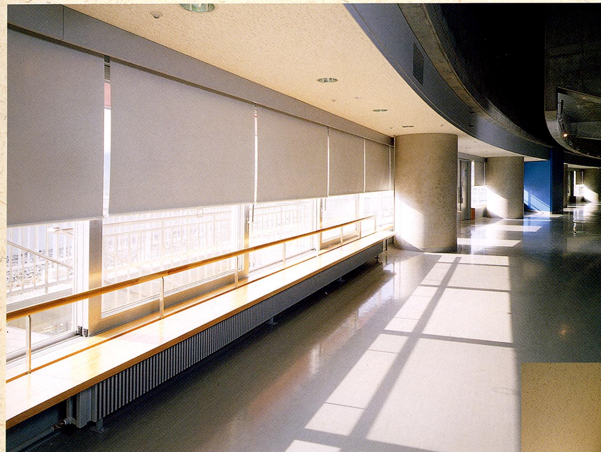
塩化ビニールにポリエステル繊維をラミネート加工した暗幕生地を使用し遮光性を高めています。
