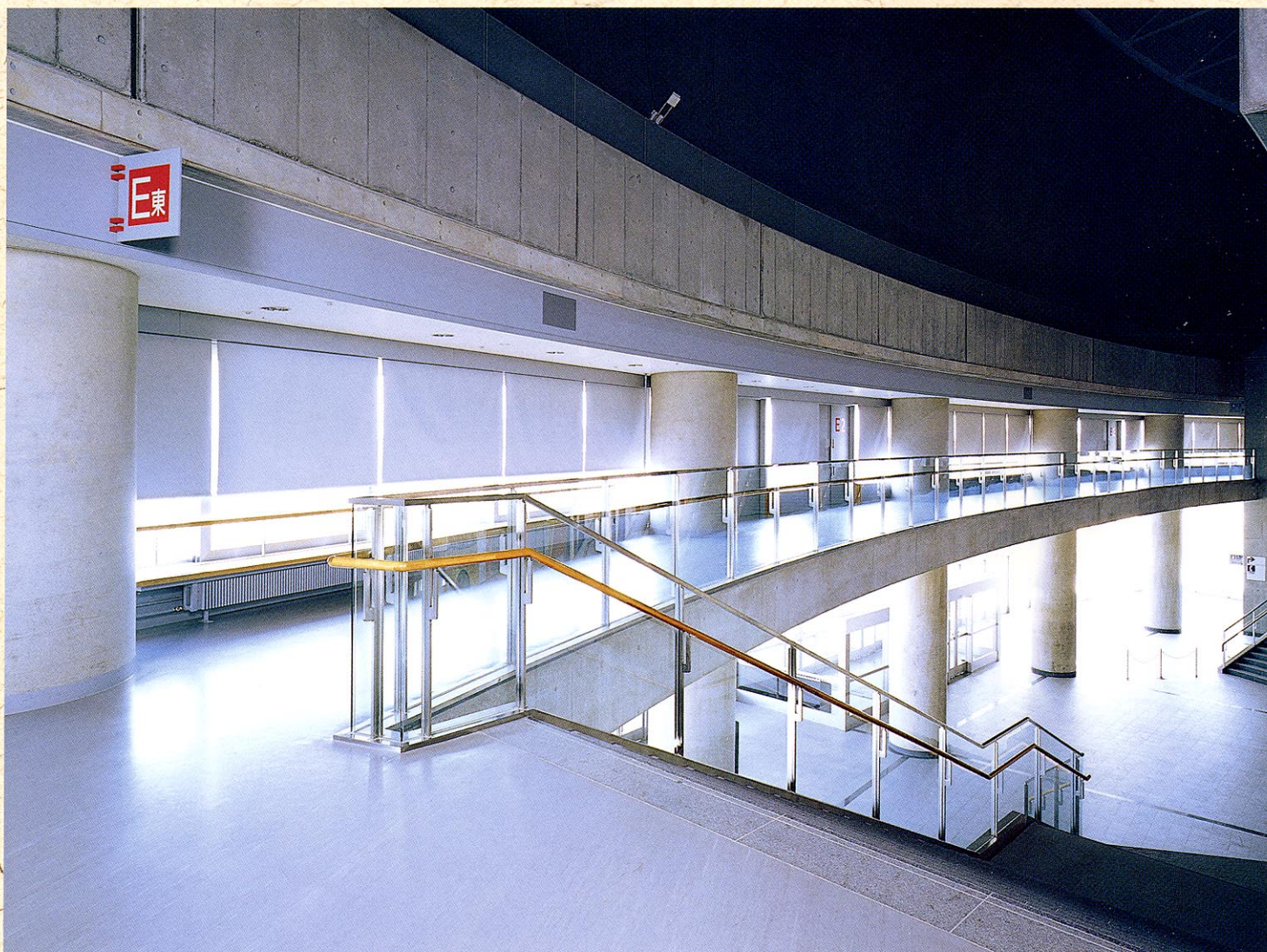
2階回廊の全周に191台のロールスクリーン「ソフィー」を設置。
