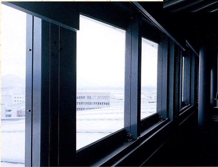
暗幕フレームでサイド・下部からの光漏れを抑えています。
