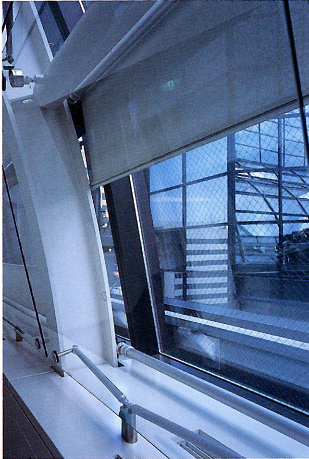
電動傾斜ロールスクリーン
