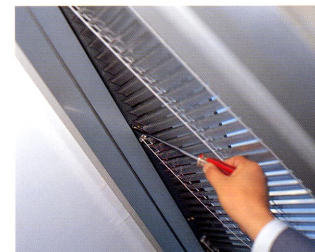
④ 引張り機構のネジをドライバーで回転させワイヤーを引張る
