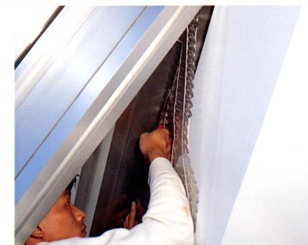
② 本体取付後固定ピンで固定
